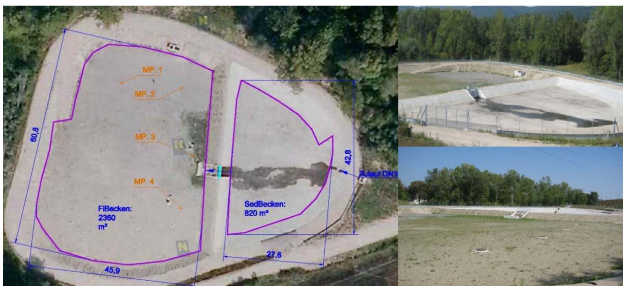
Abbildung 12: GSA A2, links Übersicht der Anlage (Luftbild: NÖ ATLAS, 2012) modifiziert, rechts oben: Sedimentationsbecken, rechts unten: Filterbecken
