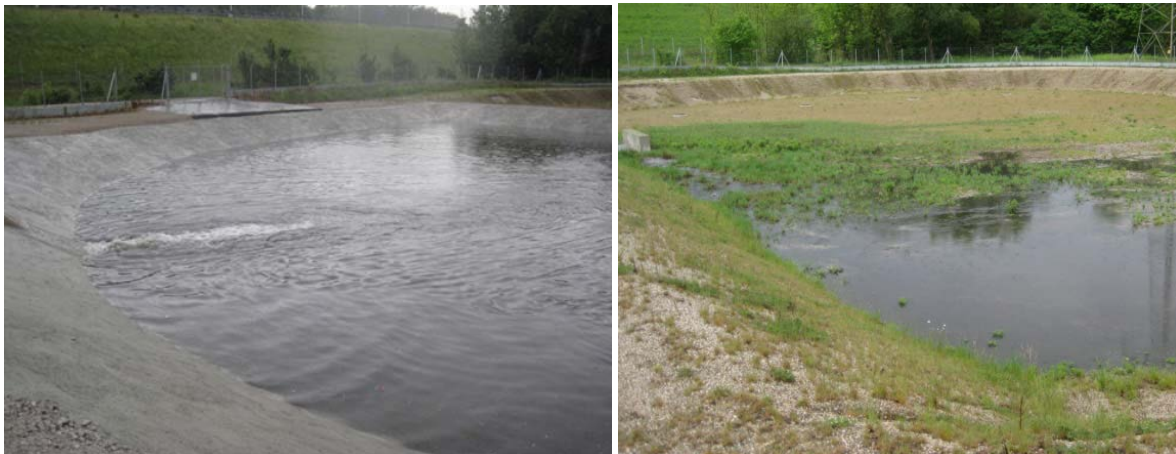
Abbildung 90: Regenereignis vom 10.06.2012 der GSA A2, links: Sedimentationsbecken, rechts: Wasserverteilung im Filterbecken
