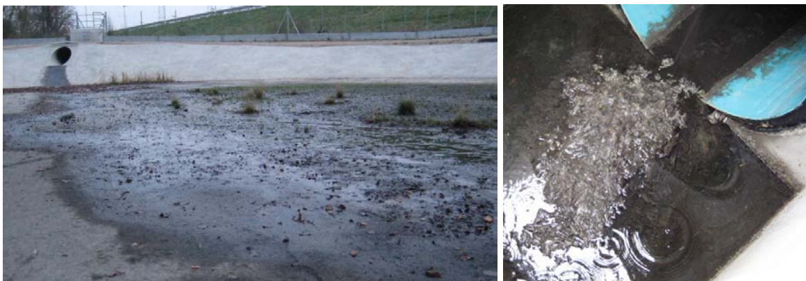
Abbildung 85: GSA A2, links: Sedimentationsbecken mit Blick auf den Zulauf, rechts: Zulaufschacht
